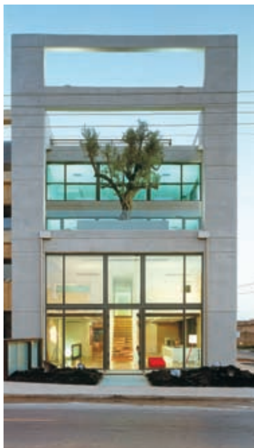
Εξωτερική άποψη των γραφείων του "Workshop"
